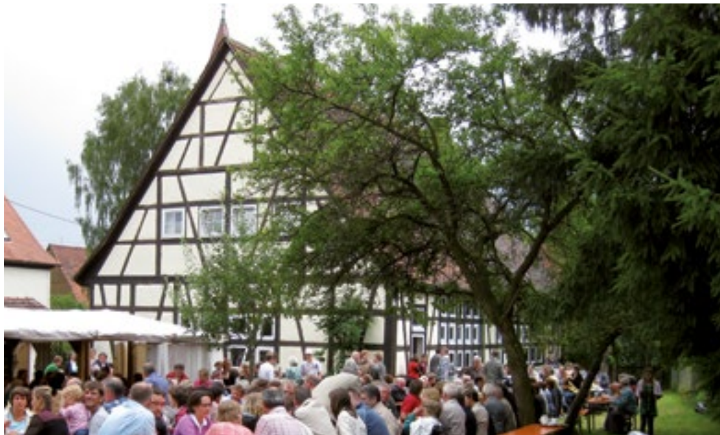
▲ Gemeindehaus Nord- und Westseite
